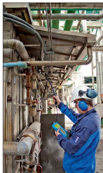
Bedrijven die leksporingen uitvoeren, stellen dat regelmatig 20 tot zelfs 40% van de geproduceerde perslucht via lekken verloren gaat.
